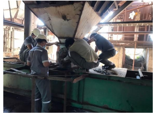
ภาพที่ 2.2-3 การซ่อมบำรุงระบบบำบัดมลพิษทางอากาศ
