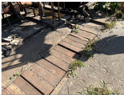
ภาพที่ 2.2-19 รางและบ่อรวบรวมน้ำทิ้งจากกระบวนการผลิต
