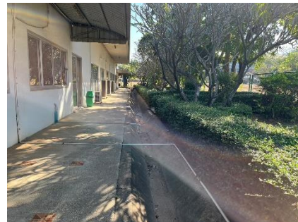
ภาพที่ 2.2-45 รางรวบรวมน้ำฝนรอบพื้นที่โครงการ
